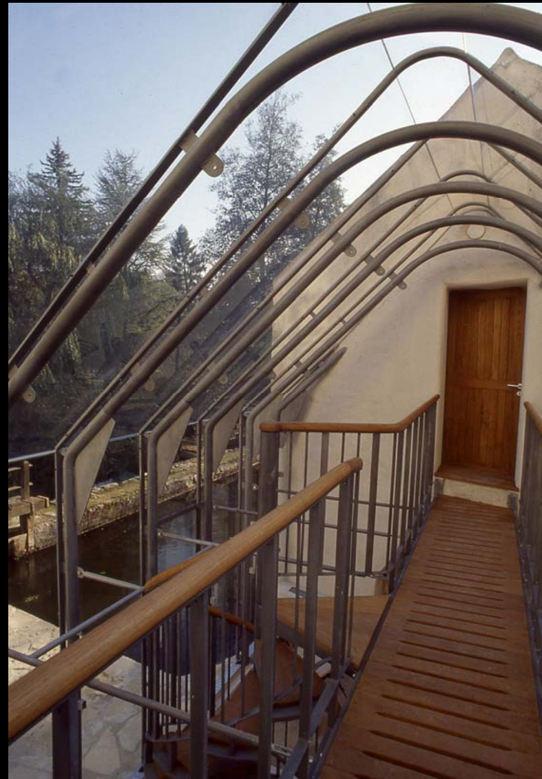
En extrémité contre le pignon sous le verre bombé de faîtage, la ventilation haute, close en hiver et ouverte en été
